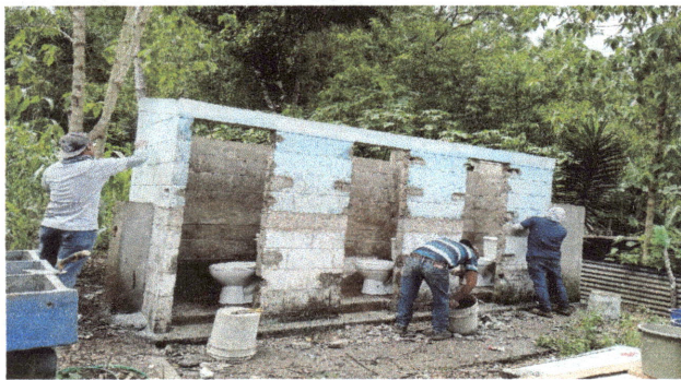
Foto 3: Estructura, techo, puertas y pintura de baños en proceso de mejoramiento.
