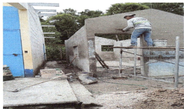
Foto 4: paredes de cocina en proceso de mejoramiento.
