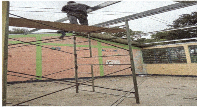
Foto 1: Estructura y techo de aulas en proceso de remodelación
