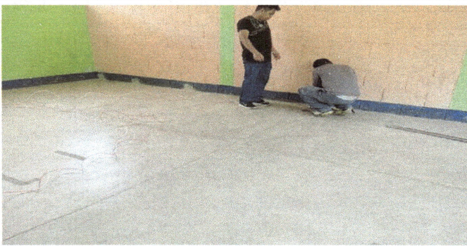
Foto 9: instalación de sistema eléctrico en procesos de aula 3.
