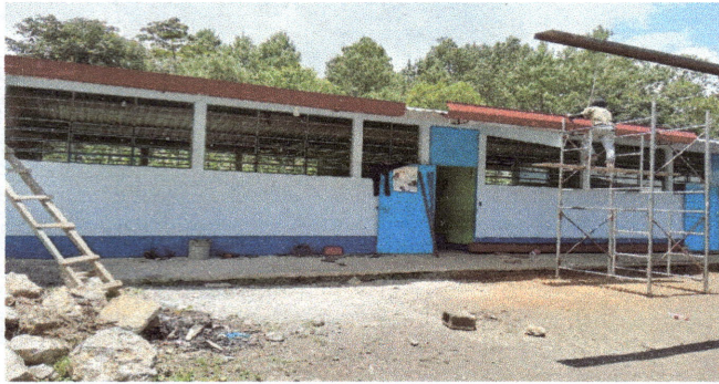
Foto 7: Colocación de canales de agua en módulo 1
