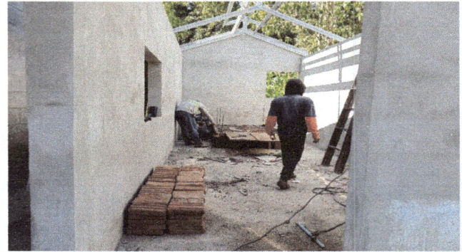
Foto 2: Estructura, techo de cocina y estufa rural en proceso de sustitución
