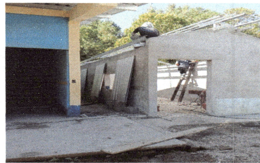
Foto 6: Instalación de estructura de techo en cocina.
